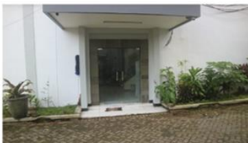
Gedung B.12 Sarana Perkuliahan Departemen Teknik Elektro
