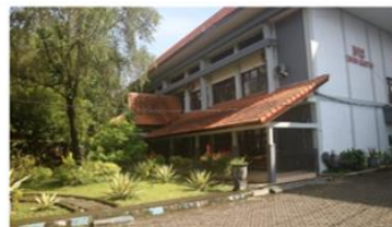
Gedung B.12 Sarana Perkuliahan Departemen Teknik Elektro
