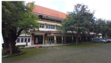
Gedung B.9 Sarana Perkuliahan Departemen Teknik Sipil
