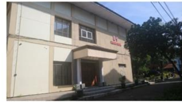
Gedung B.9 Sarana Perkuliahan Departemen Teknik Sipil
